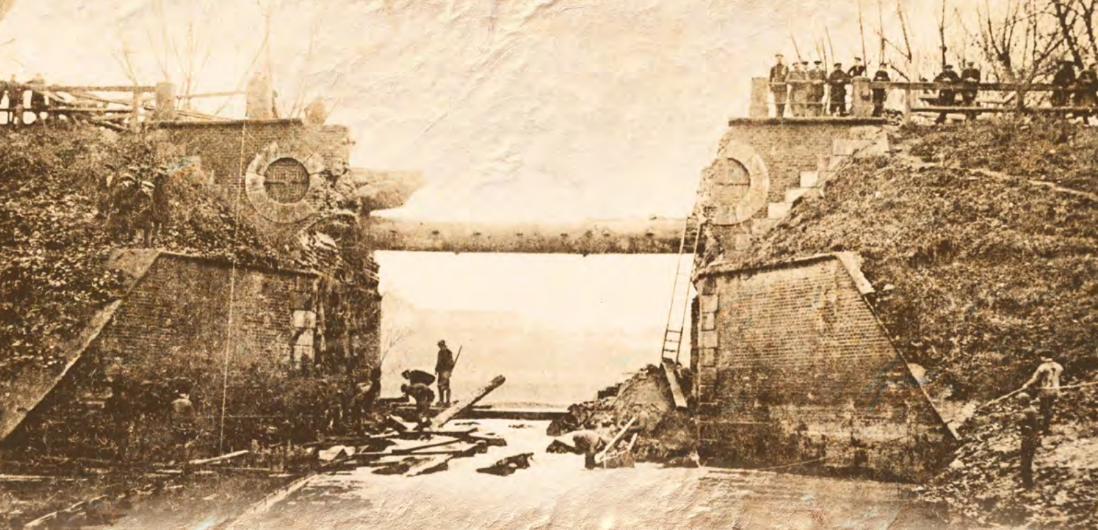
Zniszczony przez wojska rosyjskie most na Zgłowiączce w 1914 r.
