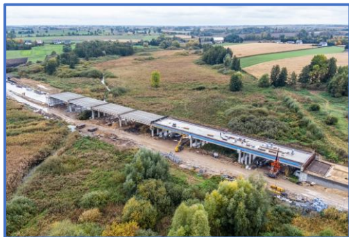
Obwodnica Mogilna (DW 254)
