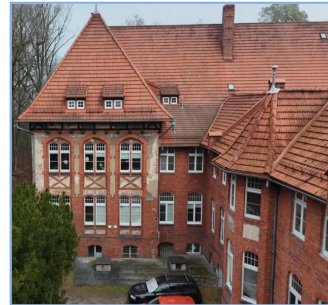
Inwestycje w infrastrukturę przy ul. Meysnera 9
