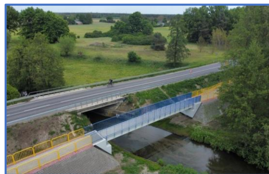
Nowa kładka w Złejwsi Małej (DW 546)
