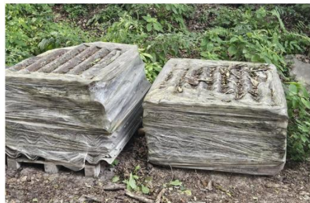
Prawidłowe składowanie płyt eternitowych przygotowanych do utylizacji
