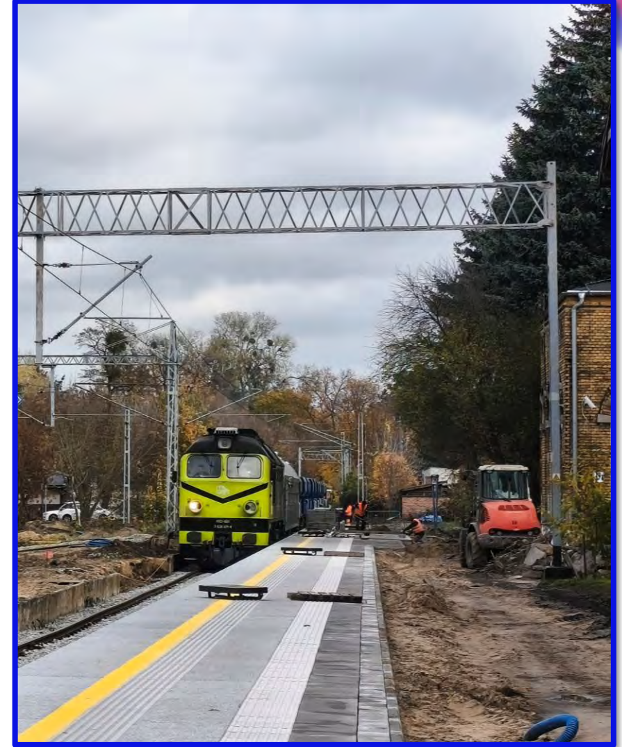
Remont linii do Ciechocinka (zakończono w grudniu 2025 r.)
