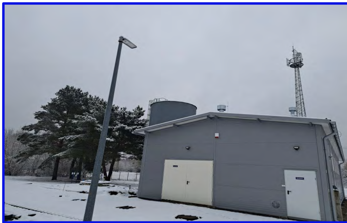
Budowa stacji uzdatniania wody w gminie Wielgie
