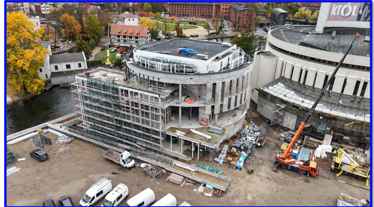
Postęp prac przy rozbudowie Opery Nova – stan na 2025 r.
