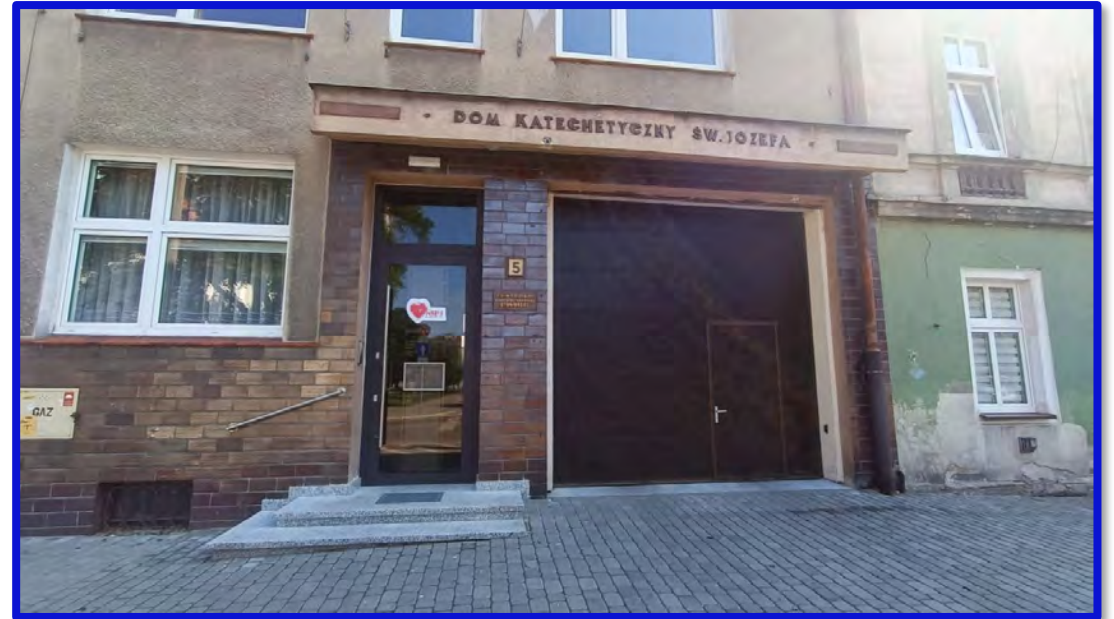
Montaż windy wraz z pracami dodatkowymi oraz adaptacja pomieszczeń przeznaczonych na Dom Diennej Pomocy na Placu Piastowskim w Bydgoszczy
