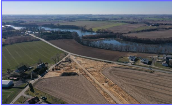
Mogilno – II etap – roboty budowlane
