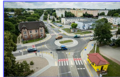
Nowe rondo w Sępólnie Krajeńskim w ciągu DW 241 – wyeliminowanie miejsca niebezpiecznego
