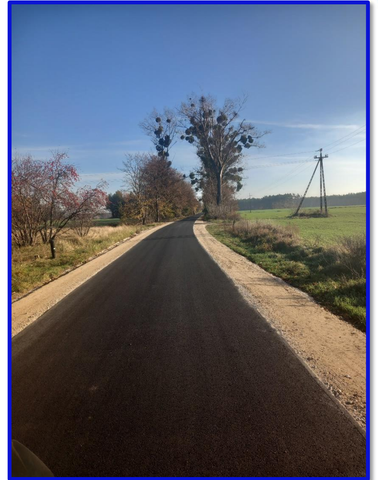
Droga dojazdowa po modernizacji w Chełmicy Małej (gm. Fabianki)
