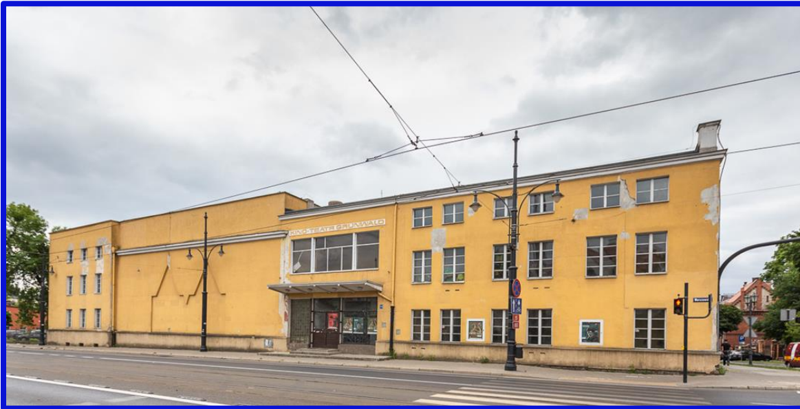
Kinoteatr Grunwald przed remontem
