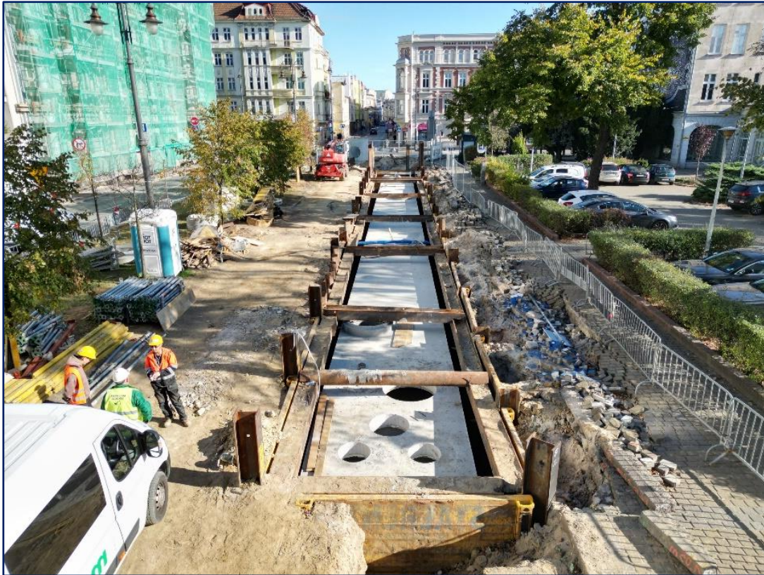
Zbiornik w czasie budowy
