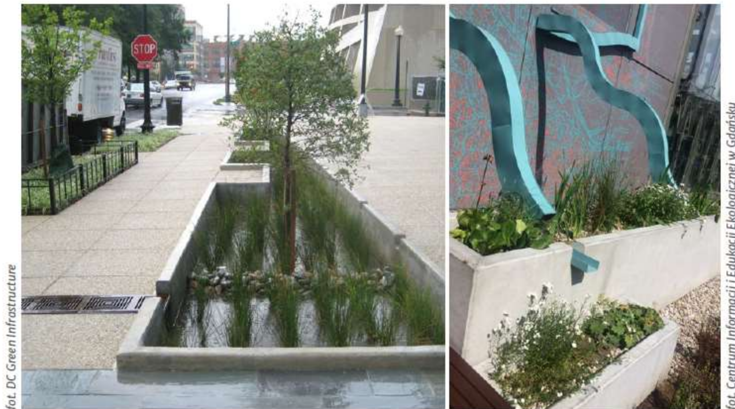
Rysunek 9. Ogród deszczowy w pojemniku: Waszyngton, Stany Zjednoczone (po lewej); przy budynku InfoBox w Gdyni, Polska (po prawej)
