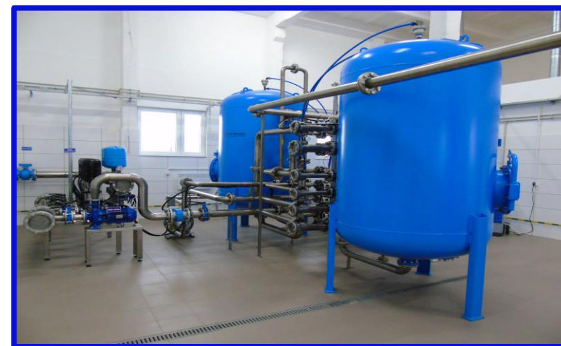
Budowa stacji uzdatniania wody w gminie Wielka Łąka
