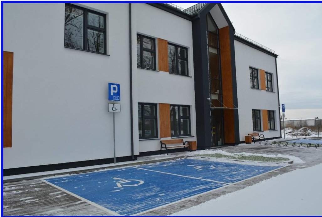
Budowa budynku szkolnego dla Zespołu Szkół nr 5 w Rypinie fot. Powiat Rypiński
