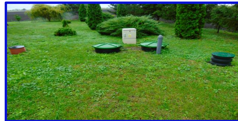
Budowa przydomowych oczyszczalni ścieków w gminie Lubraniec
