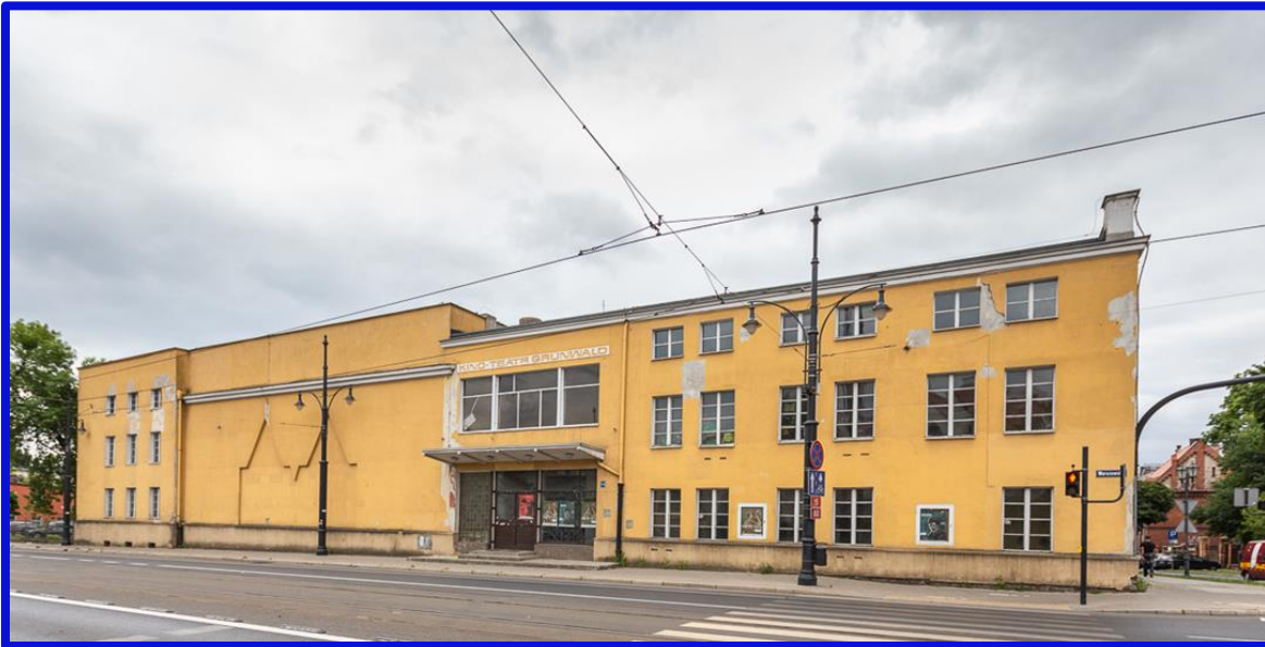
Kinoteatr Grunwald przed remontem
