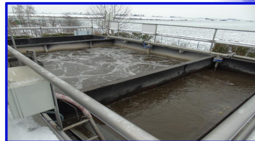
Budowa oczyszczalni ścieków w Lubrańcu
