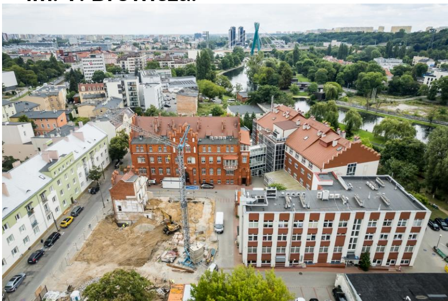
Rozbudowa Szpitala Obserwacyjno-Zakaźnego im. T. Browicza w Bydgoszczy
