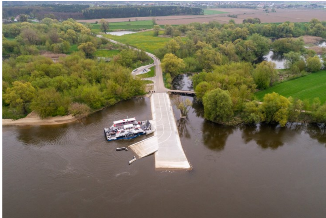
Przebudowana droga wojewódzka nr 249 Solec Kujawski - Czarnowo wraz z nowo powstałą przeprawą promową, fot. Szymon Zdziebło
