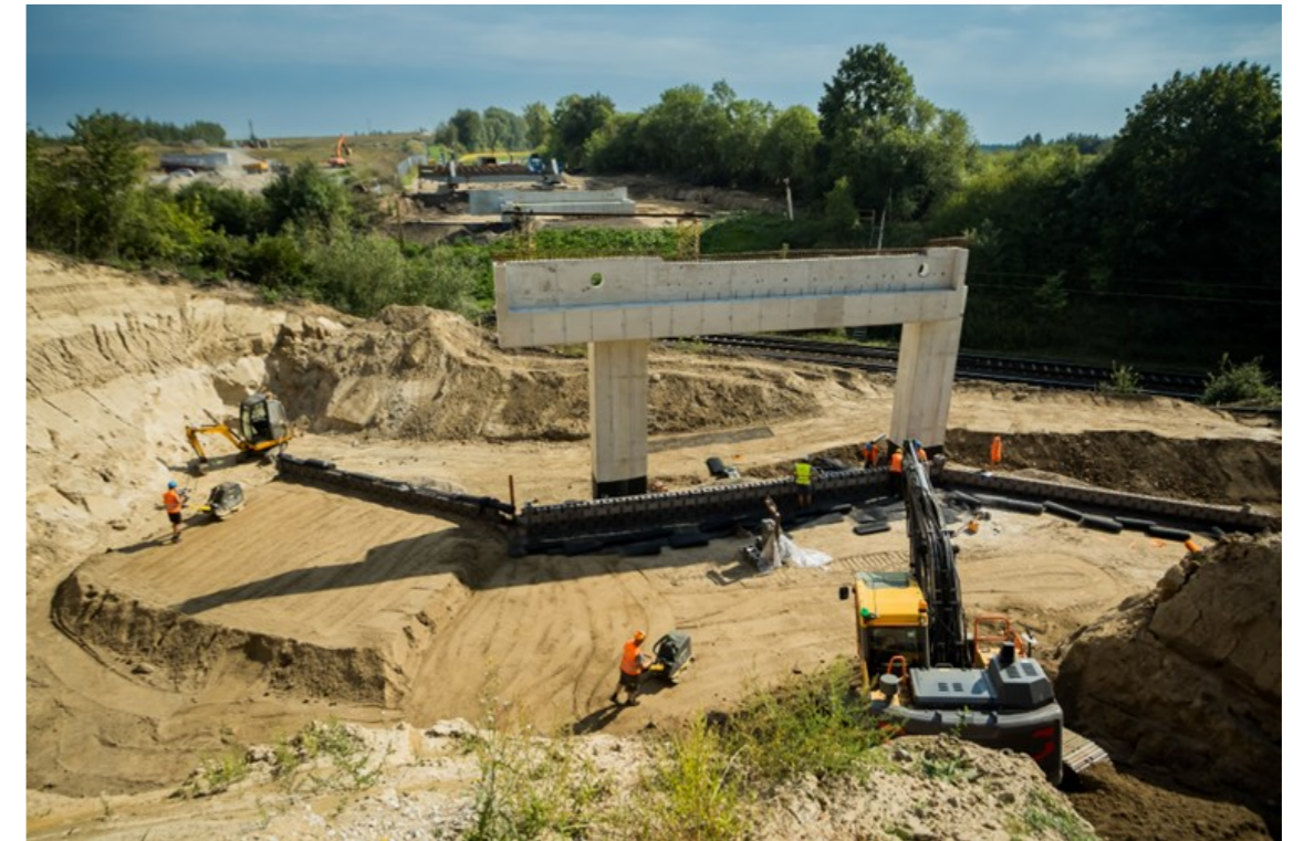
Przebudowa wiaduktu na DW 240 Chojnice – Świecie w miejscowości Terespol Pomorski, fot. Tomasz Czachorowski
