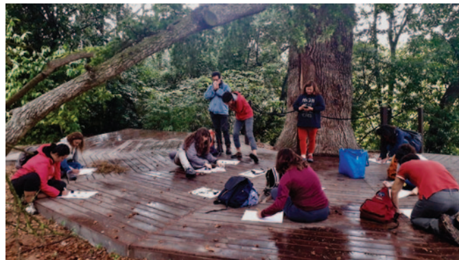
Zdjęcia 25-28: Budowa drewnianej platformy
