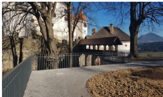
Zdjęcia 39-42: zdjęcia u góry - stan przed renowacją, zdjęcia u dołu - stan po renowacji
