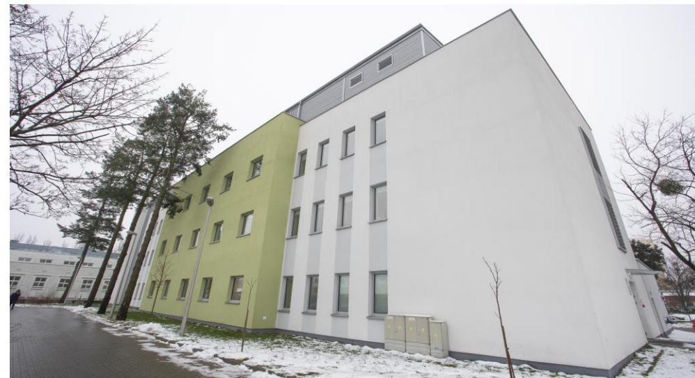
Nowy budynek oddziału zakaźnego im. dr Wandy Błęńskiej
