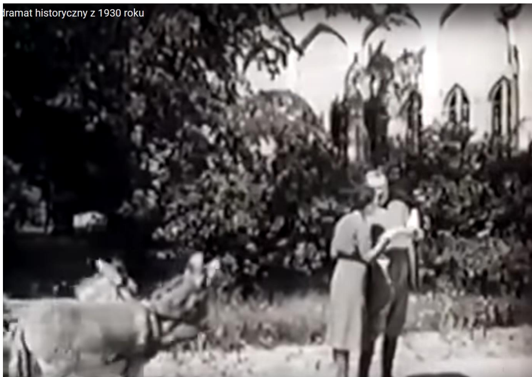
Ilustr. 55. Wieniec. Widok na południową elewację starego pałacu i nasadzenia przed południową elewacją. Kadr z filmu „Na Sybir” z 1930 r. Źródło: https://www.youtube.com/watch?v=vGn4llwePqs
