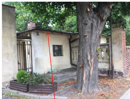
Wieniec, szeroki okap dachu na budynku bramnym
