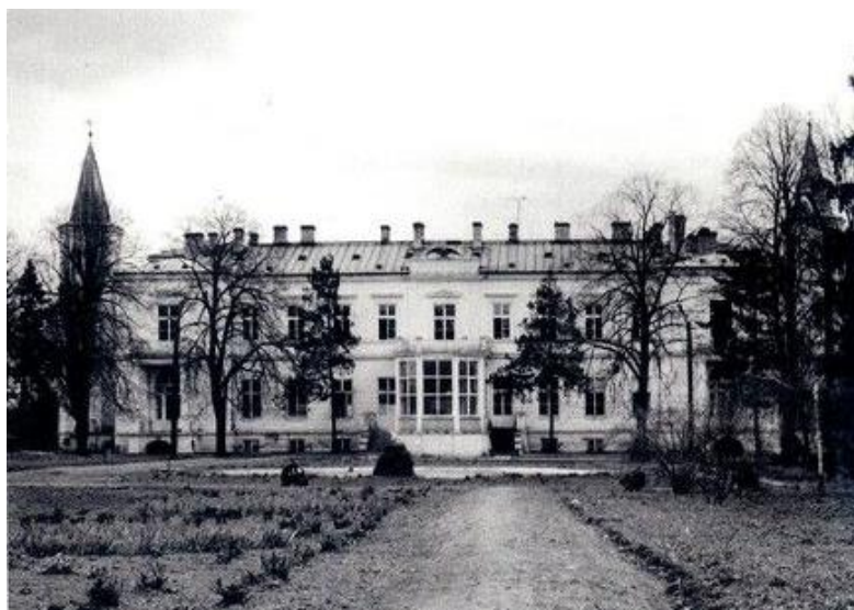
Ilustr. 65. Wieniec. Widok na elewację ogrodową pałacu. Stan z 1970 r. Źródło: https://plus.polskatimes.pl/
