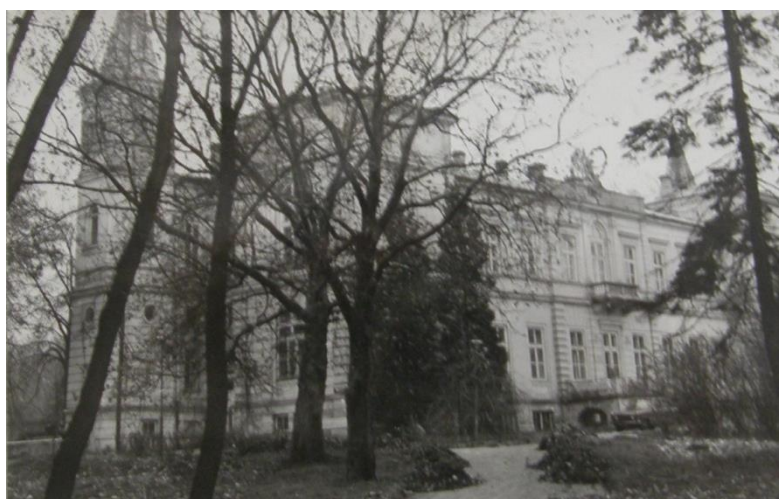
Ilustr. 67. Wieniec. Widok na południową i frontową (wschodnią) elewację pałacu. Stan bez podjazdu dla karetek. Stan z grudnia 1980 r. Źródło: archiwum K-P WKZ w Toruniu, Delegatura we Włocławku
