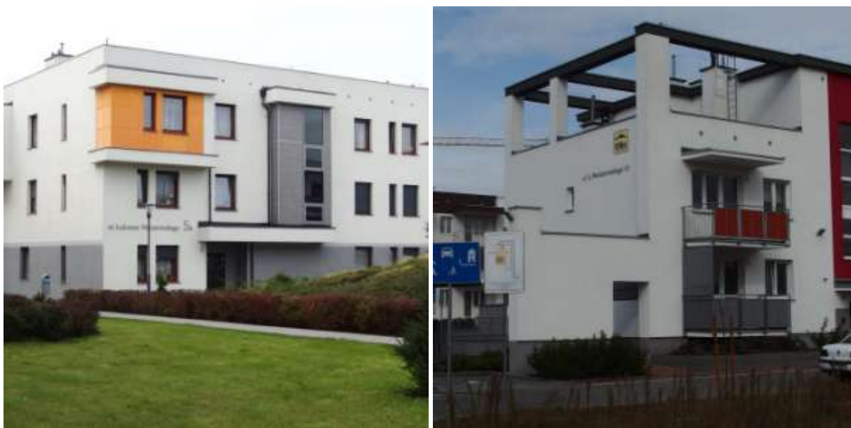
Ryc. 76. Po lewej – jeden z budynków Osiedla JAR w części wybudowanej przez dewelopera i należącej obecnie do wspólnoty mieszkaniowej; po prawej – budynek na Osiedlu JAR w części wybudowanej przez TBS
