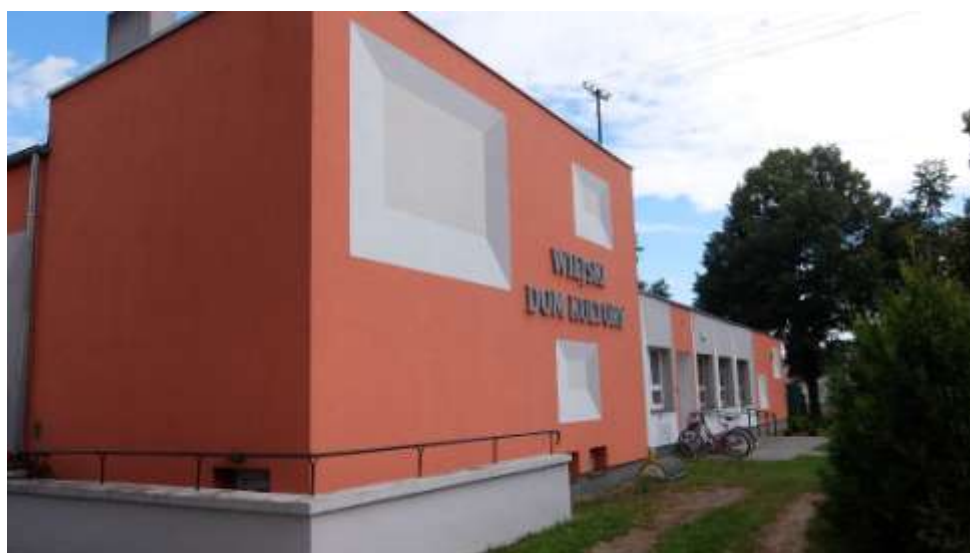
Ryc. 89. Wiejski Dom Kultury w Kęsowie
