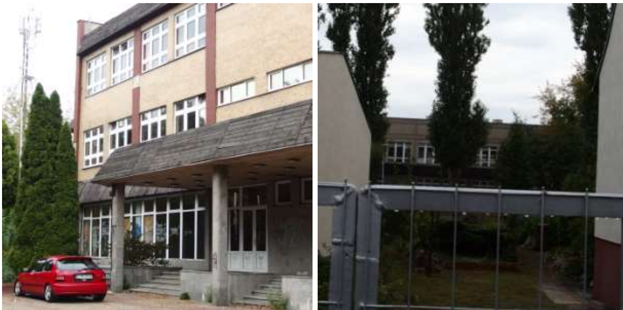
Ryc. 75. Po lewej – budynek po TORPO, po prawej – widok na budynek TORPO z perspektywy ulicy między domkami jednorodzinnymi
