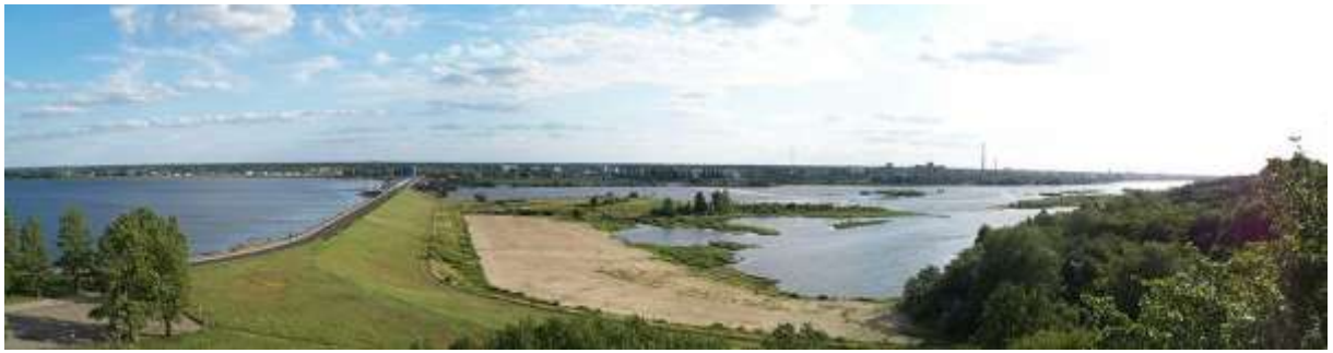
Ryc. 69. Elektrownia wodna we Włocławku
