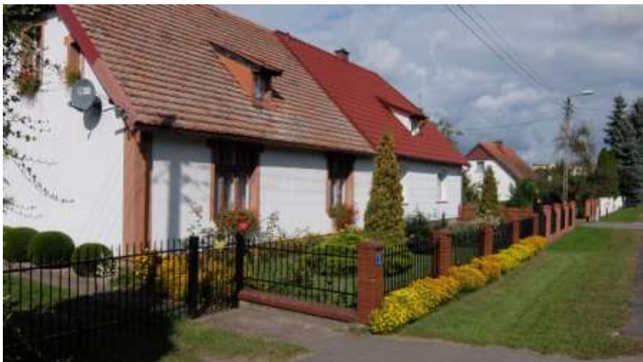
Ryc. 94. Przykład zagospodarowanej posesji wzdłuż ulicy Szkolnej w Kęsowie
