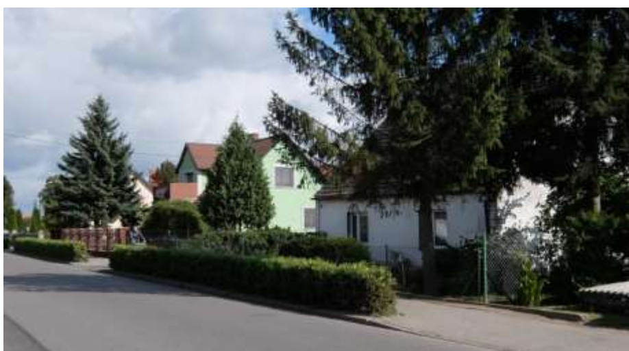
Ryc. 93. Nowa infrastruktura drogowa Kęsowa – drogi i chodniki po inwestycjach rewitalizacyjnych
