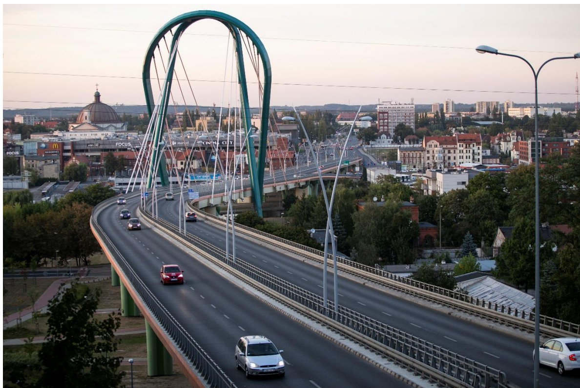
Trasa Uniwersytecka w Bydgoszczy – w 2018 roku trwały prace związane z jej przedłużeniem w kierunku południowym, fot. Filip Kowalkowski
