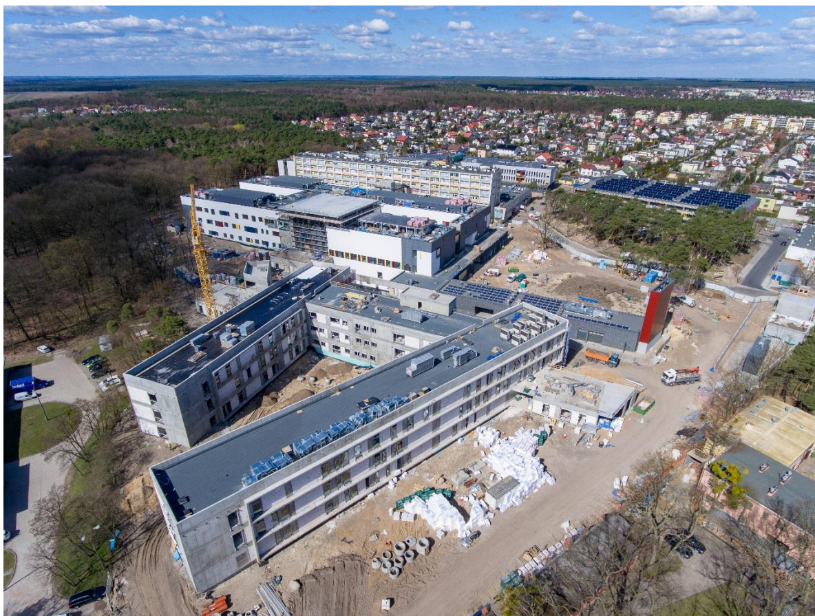
Budowa WSZ w Toruniu, fot. Sky Dron Studio dla KPIM
