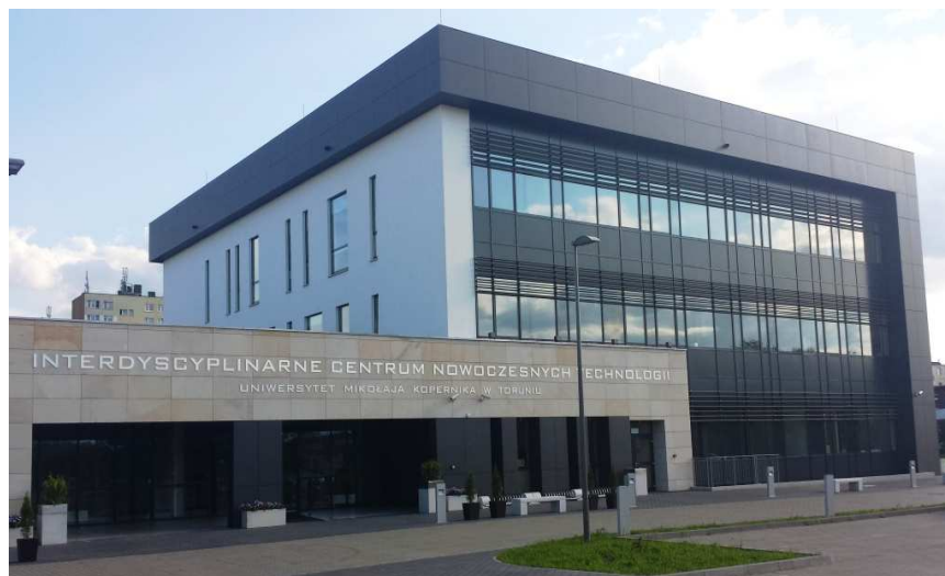
Budowa Interdyscyplinarnego Centrum Nowoczesnych Technologii UMK w Toruniu
